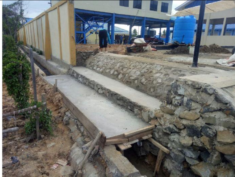
Gambar g: Pembangunan turap/ revetment di PPI Sebatik (DAK)
