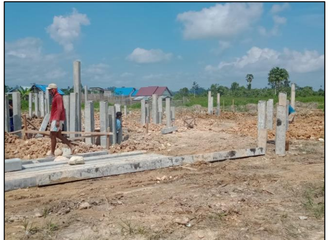
Kupasan/Pemotongan Tiang Beton Mini Pile
