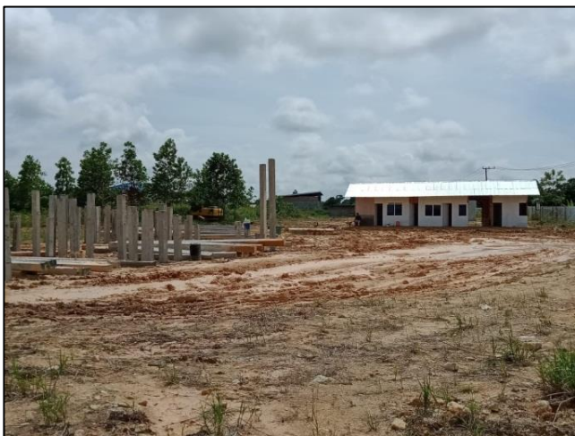
Pemancangan Tiang Beton Mini Pile 20 x 20 cm
