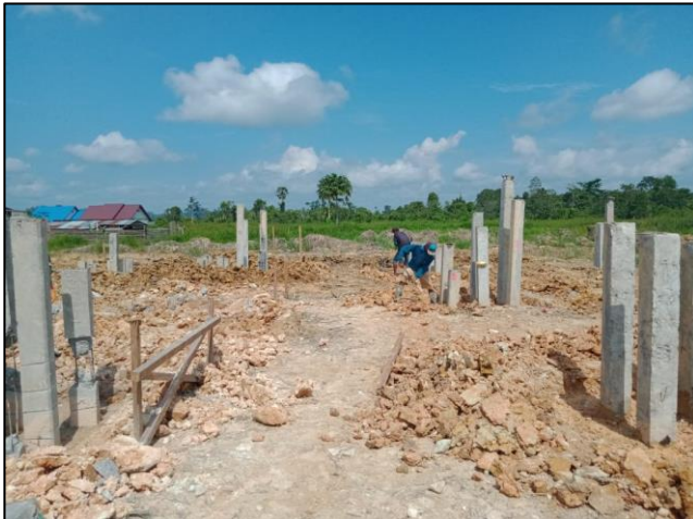
Kupasan/Pemotongan Tiang Beton Mini Pile
