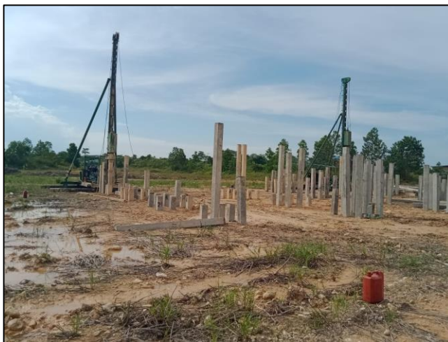
Pemancangan Tiang Beton Mini Pile 20 x 20 cm
