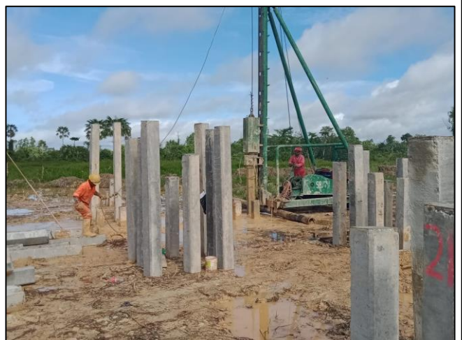
Pemancangan Tiang Beton Mini Pile 20 x 20 cm
