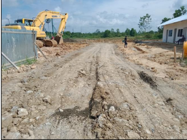
Pembuatan Jalan Masuk sementara
