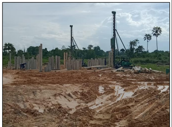
Pemancangan Tiang Beton Mini Pile 20 x 20 cm
