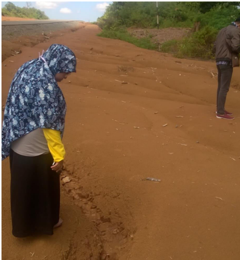
Gambar 3.12. Kejadian erosi parit di sisi jalan arteri yang dibangun Pemerintah Kabupaten Tana Tidung.
