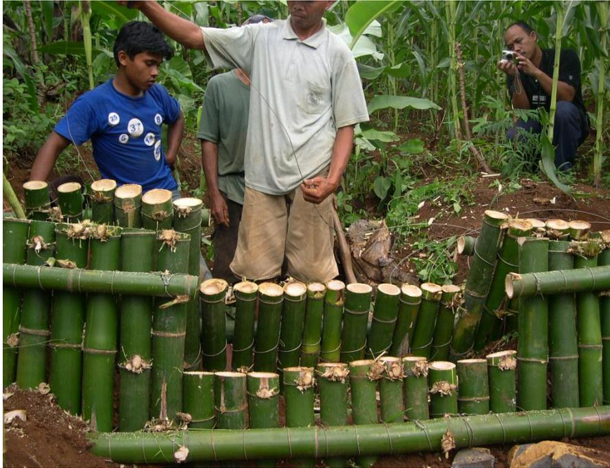
Gambar 4.45. *Bio Gully Plug* tampak depan di lapangan
