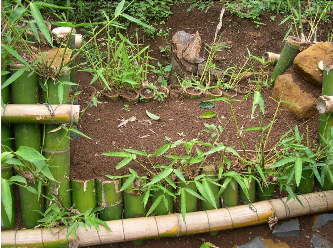
Gambar 4.46. *Bio Gully Plug* telah terisi tanah dan tanaman bambu mulai tumbuh
