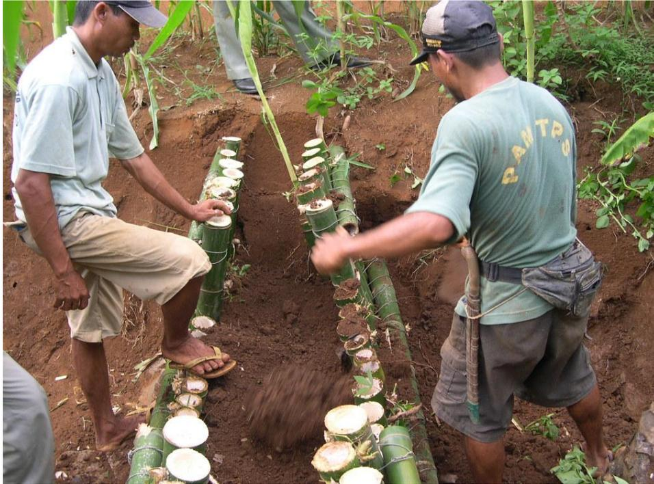
Gambar 4.43. Proses pembuatan *Bio Gully Plug*
