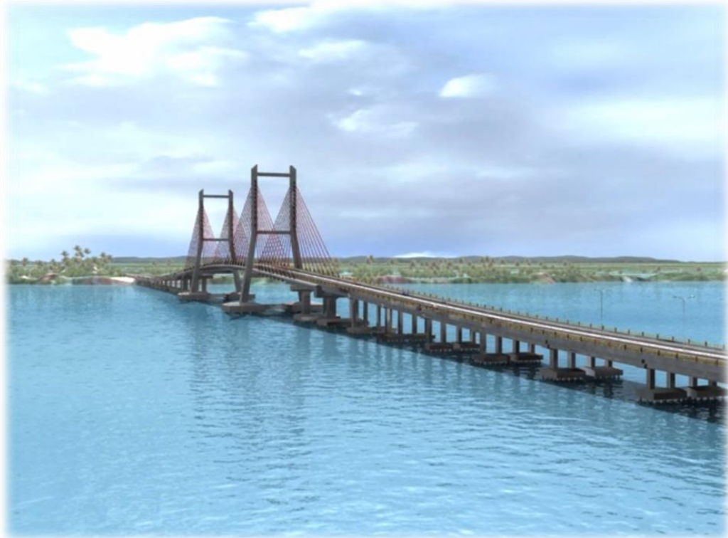
Gambar 2.6 Pembangunan Jembatan Bulan (Bulungan-Tarakan)
