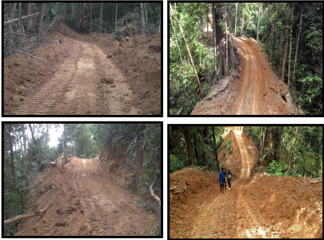
Gambar 2.4 Pembangunan Jalan di Daerah Perbatasan
