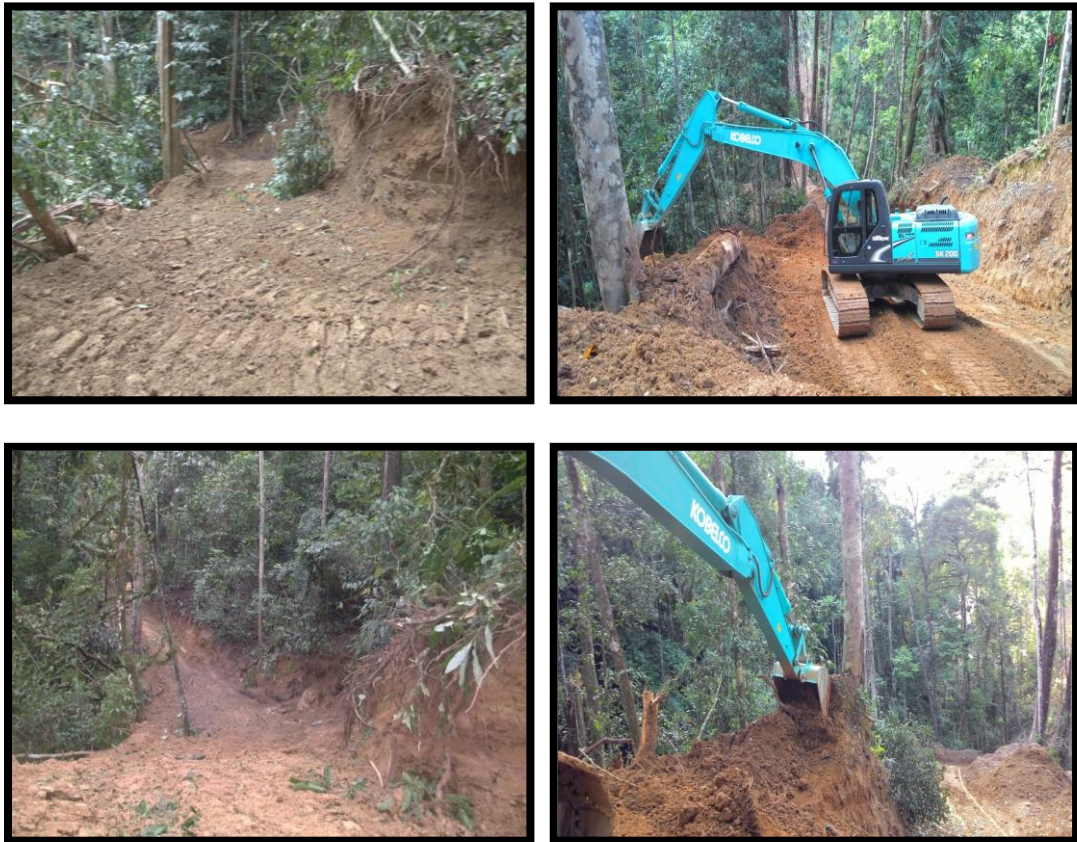
Gambar 2.5 Pembangunan Jalan di Daerah Perbatasan
