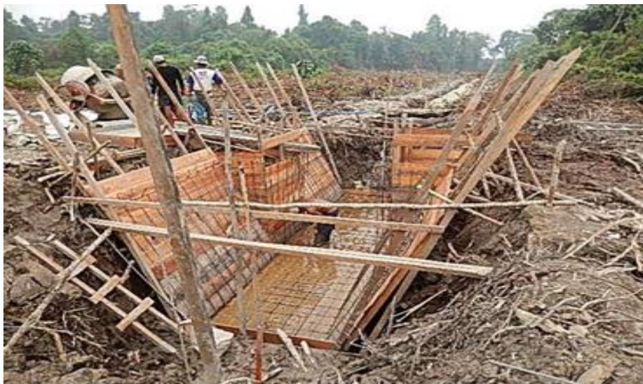
Gambar 2.21 Proses Pembangunan Pintu Air
